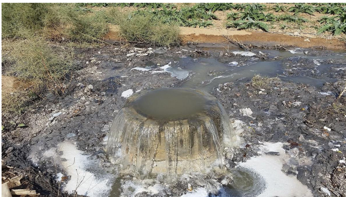
Colector de aguas residuales en Murcia desbordado por las toallitas
