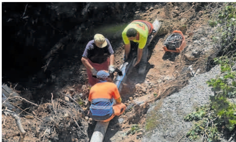
Tres operarios trabajan ayer para reparar los daños en la red de abastecimiento de Tudela de Duero. L. A. D.
